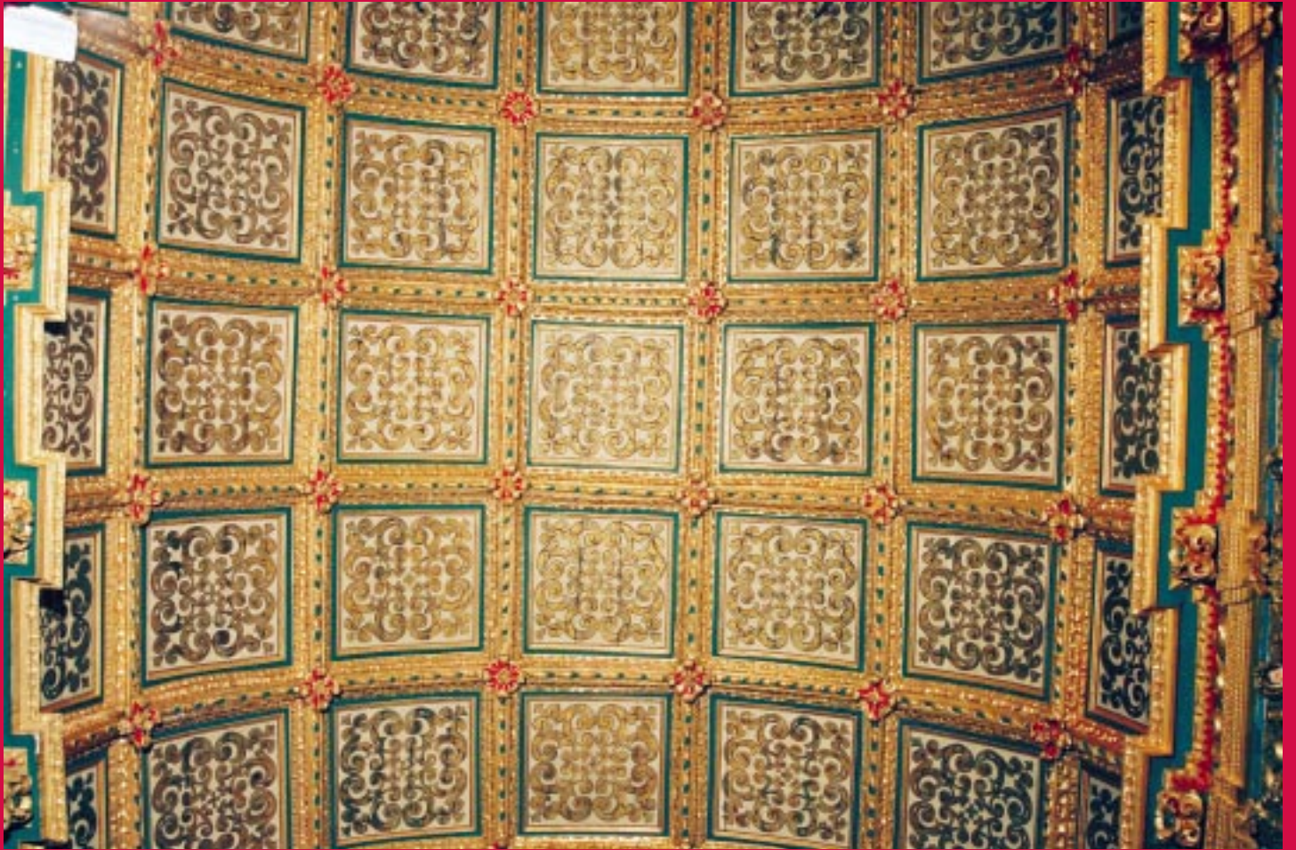
Pormenor do forro do tecto da capela-mor da igreja do extinto convento de Santa Ana, Viana do Castelo.
